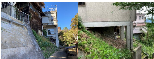
図6・7：RC造の「ツッカエ（表出柱）」を用いた吉野建ての例
